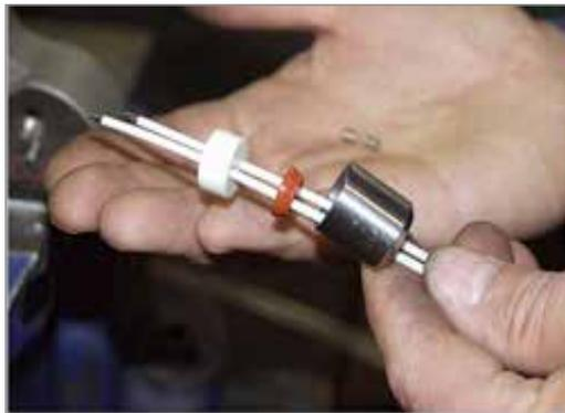
4. Schieben Sie Crimps auf die Kabel. Die Litzen sollten über den Crimp hervorstehen.
