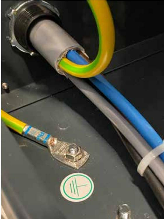
Figura 3-2 Esempio di collegamento a terra
