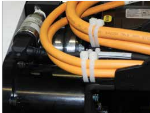
Illustration 7-2 Les câbles sont maintenus en place par des attaches de fil.
