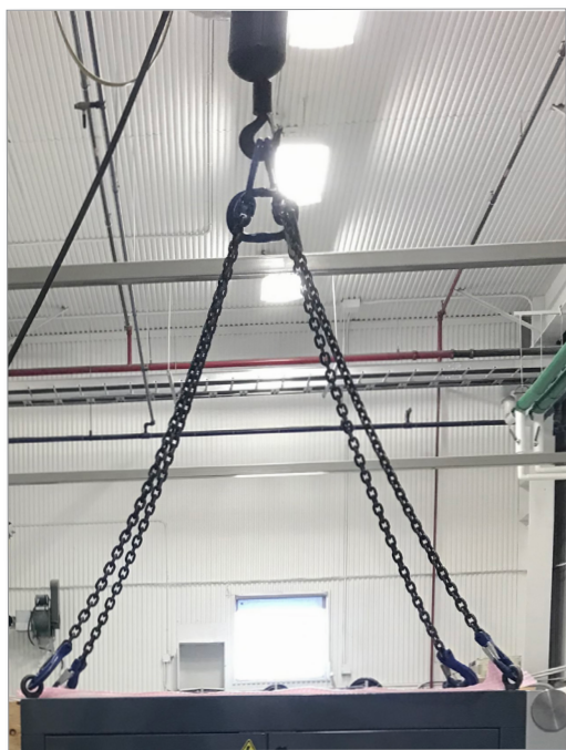
Abbildung 3-11 Befestigen Sie Schlaufen an allen vier Ringschrauben.
