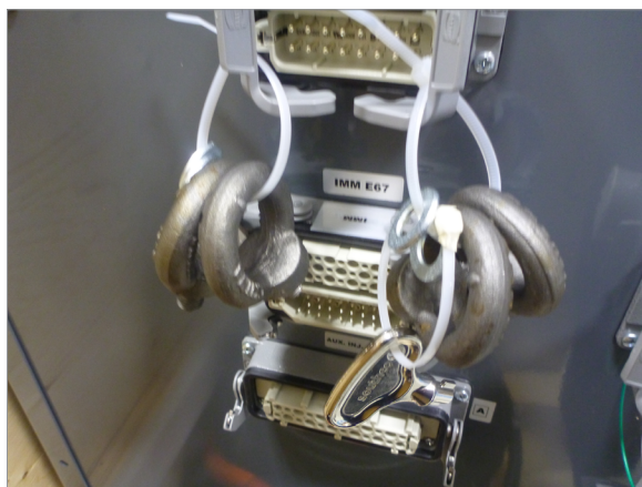
Figure 3-9 Cáncamos y arandelas
